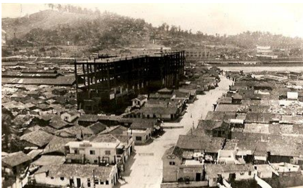
Imagem 10: A “Favela do Esqueleto”, construção abandonada que, com a retirada dos moradores do entorno, em 1960, foi recuperada dando origem a atual UERJ. Ao fundo, o morro da Mangueira. Vizinhança partida pela construção dos elevados da autovia Radial Oeste, estações de trem e metrô, passa a ser explorada pela aproximação através da ponte de afetos. Extensão, ensino e pesquisa estão se produzindo como forças de trabalho nessa construção. < fonte: coleção UERJ/ Rede Sirius de Bilbliotecas >
